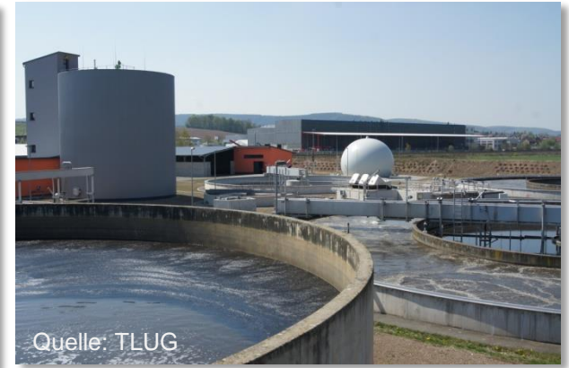
Nährstoffreduzierung durch Abwassermaßnahmen
